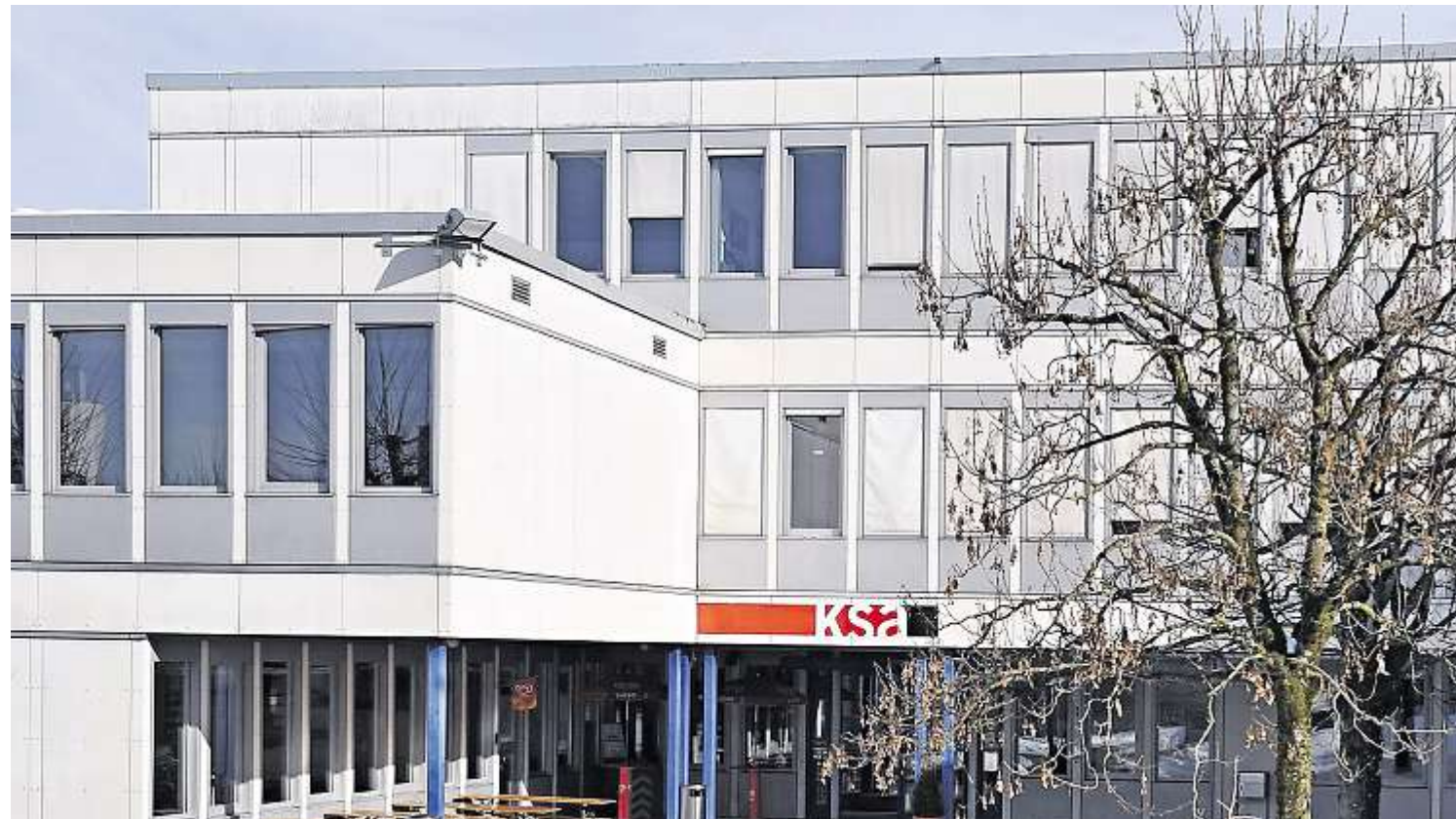
Die Kantonsschule Ausserschwyz in Pfäffikon: Hier könnten künftig 100 bis 200 Schüler aus Rapperswil-Jona unterrichtet werden. Bild: Archiv ZSZ
