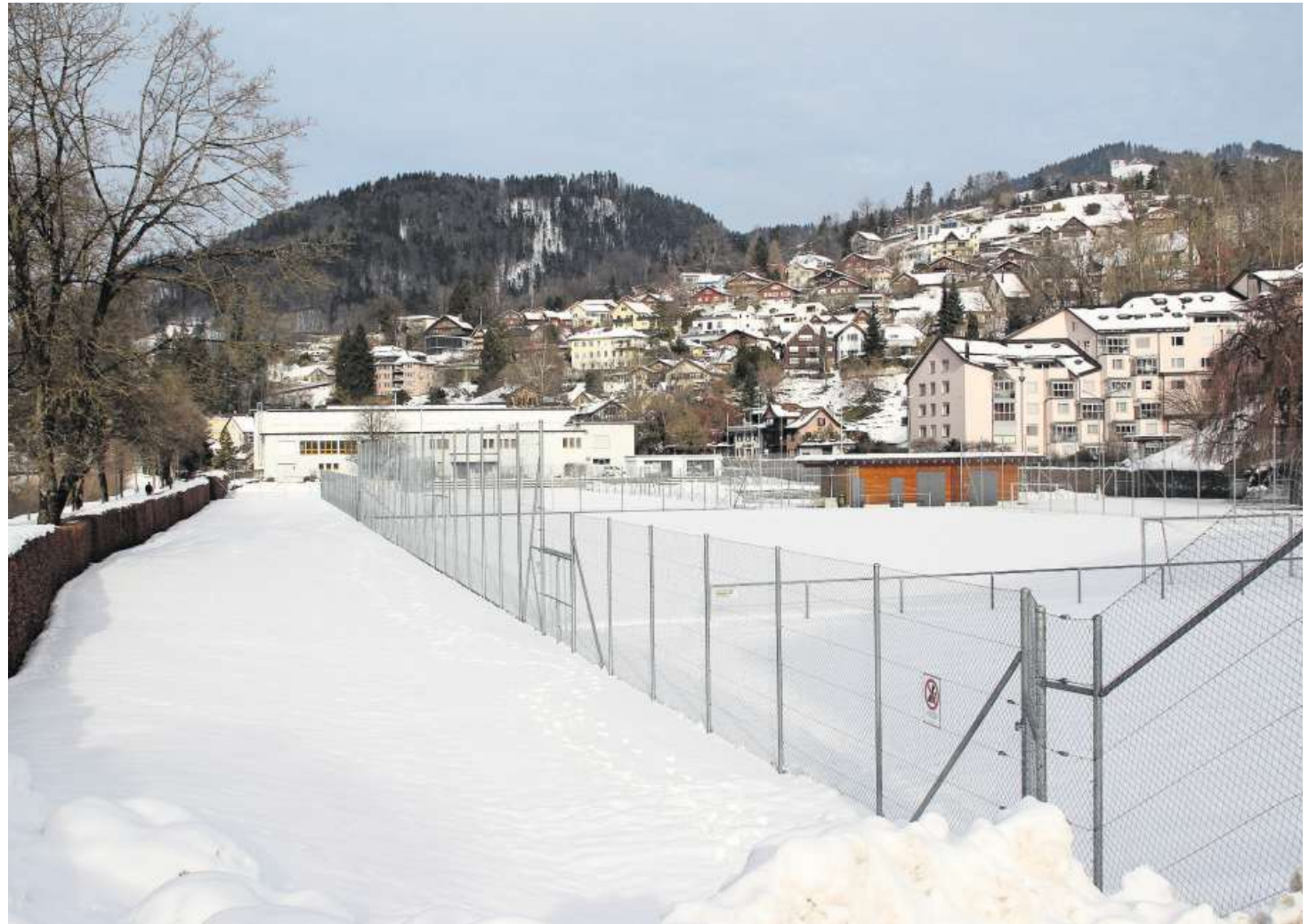
Auf diesem Areal soll die neue Kanti Wattwil erstellt werden. Das Areal liegt im Kataster belasteter Standorte.
